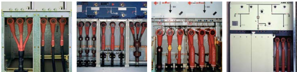
Siemens 8DJ10 Groupe Schneider RM6 AREVA FBA ABB CTC
